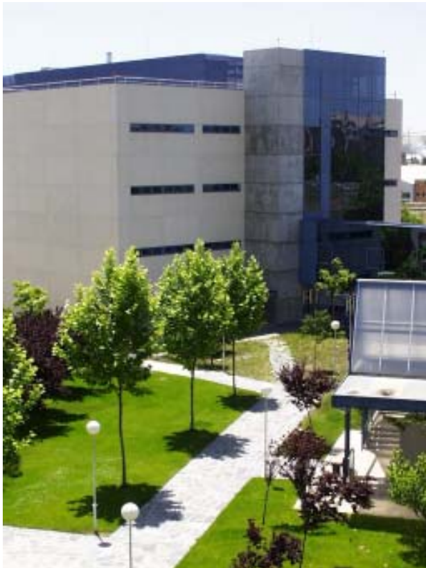
Centro de estudios aeronáuticos (Madrid, edificio nuevo)
