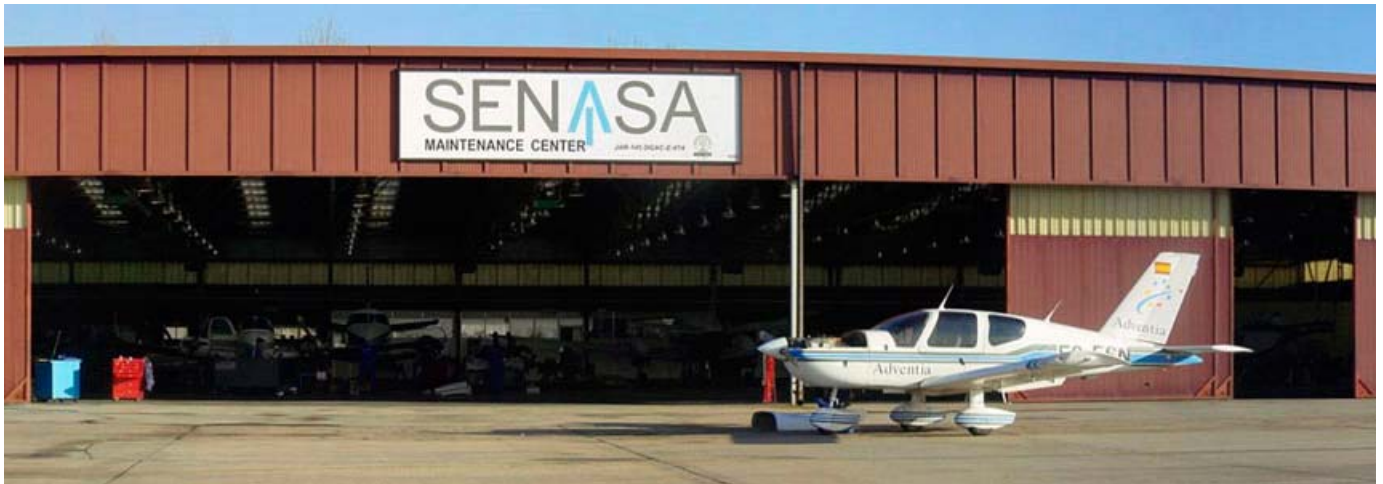
Centro de Mantenimiento de Salamanca
