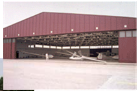
Hangar de Ocaña
